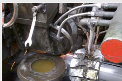
Temperaturüberwachung der Rohrränder kurz vor dem Verschweißprozess
