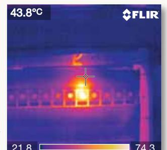
Das Infrarotbild zeigt eindeutig die Überhitzung einer Sicherung. Dies kann fatale Konsequenzen haben. Es kann zum Produktionsstillstand kommen, wenn der Fehler nicht rechtzeitig entdeckt und behoben wird.
